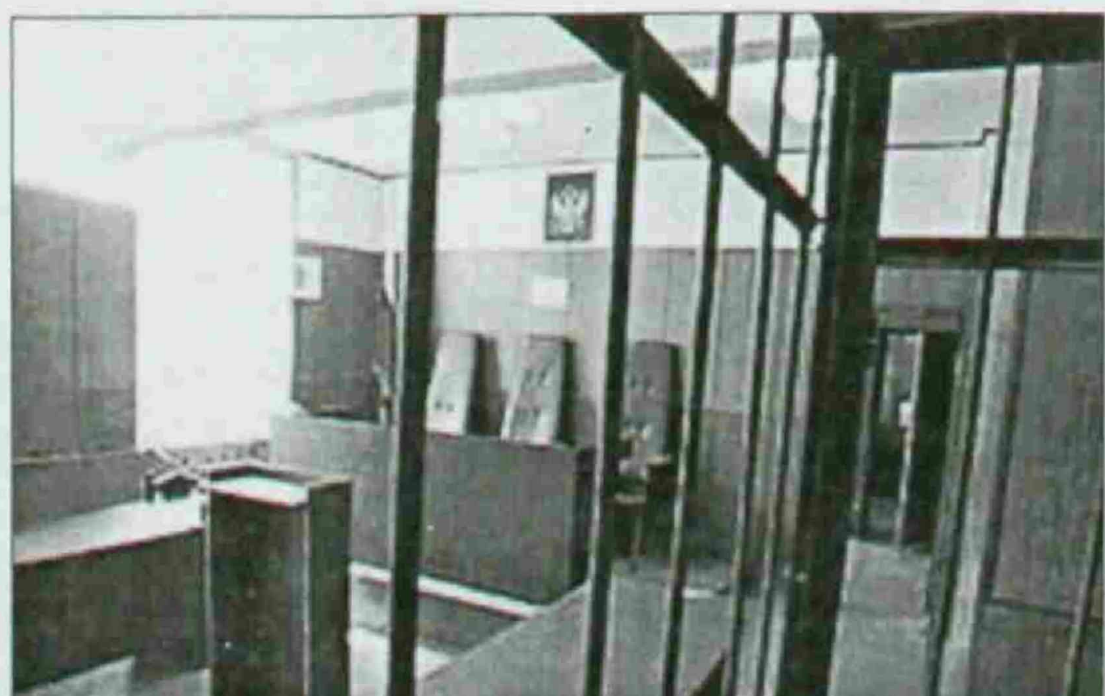
В подобном здании судьи будут работать сегодняшние студенты юридического факультета КГУ
